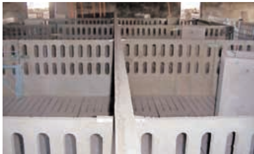
Colocar tabiques de separación entre los corrales de plancha de fibrocemento.
