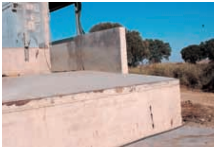
Muelle de carga y descarga de animales que se debe localizar al lado del vallado para evitar que los camiones entren en la explotación.
