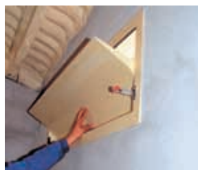
Entrada de aire por deflector.
